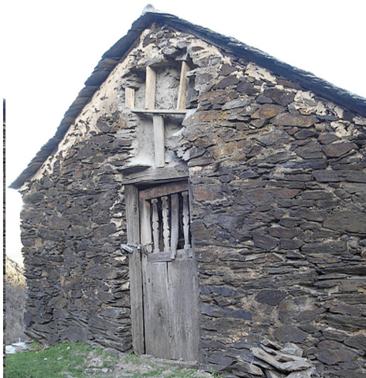
2. Fachada de la ermita después del robo
